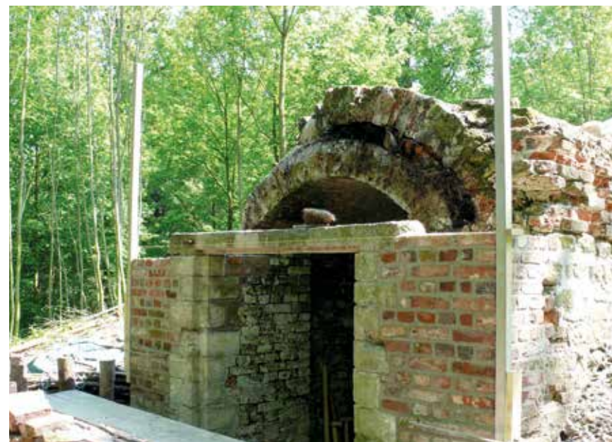
Dubbel gewelf ijskelder Kasteel de Ribaucourt (RLGC vzw)
