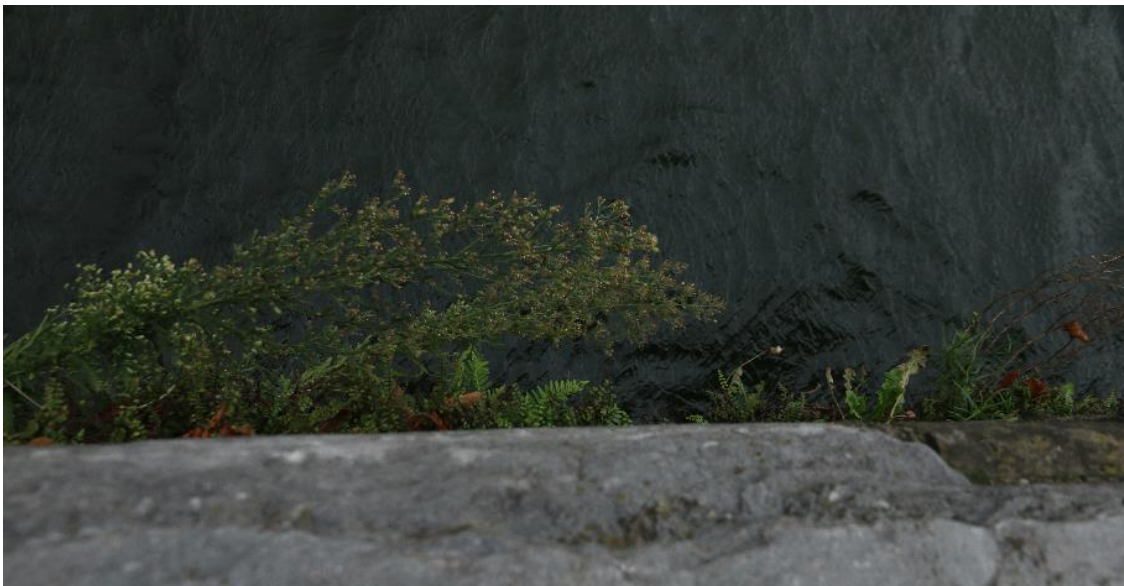
Figuur 6: Locatie eikvaren, onderaan de muur op een plaats waar geen steigers zijn.
